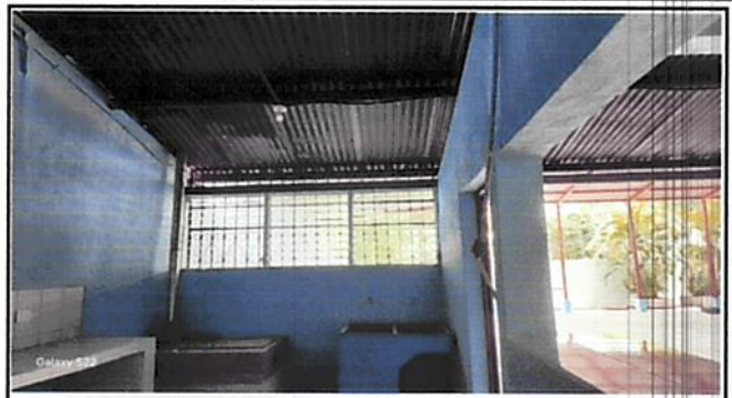
Foto 2: fabricación e instalación de ventana en cocina
