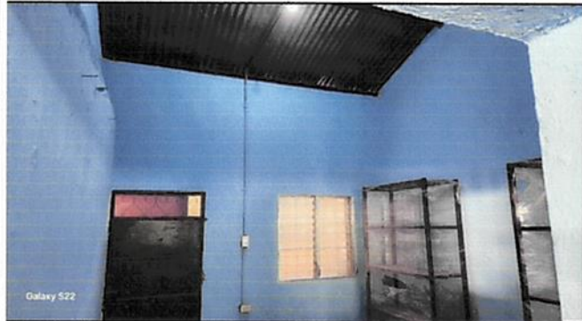
Foto 1: Pintura en cocina interiores
