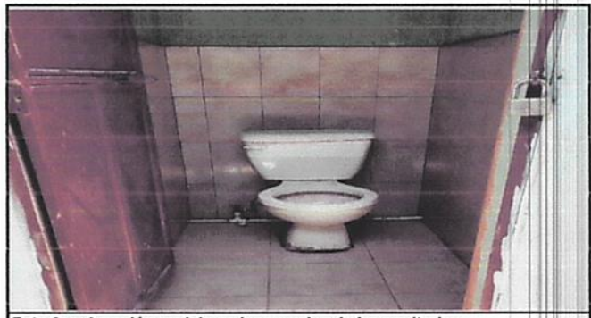
Foto 6: colocación azulejo en las paredes de los sanitarios
