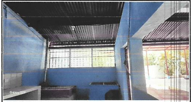
Foto 2: fabricación e instalación de ventana en cocina
