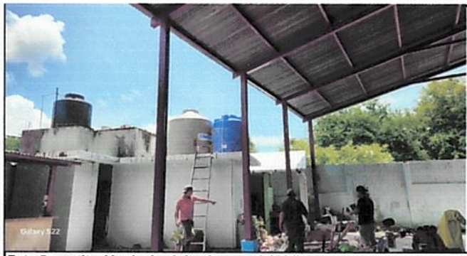
Foto 5: sustitución de depósito de agua 1,100 litros
