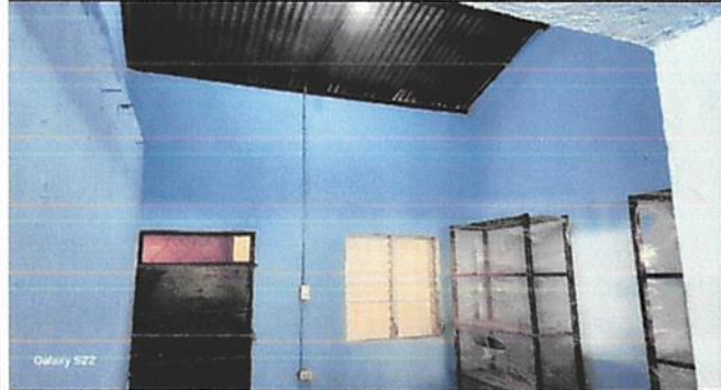
Foto 1: Pintura en cocina interiores
